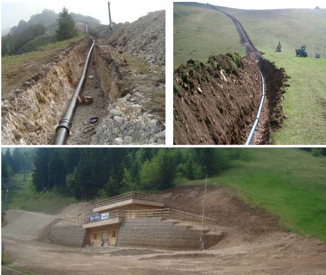
Nuova sala di pompaggio di rinvio in loc. Bucaneve – San Valentino (Brentonico)
