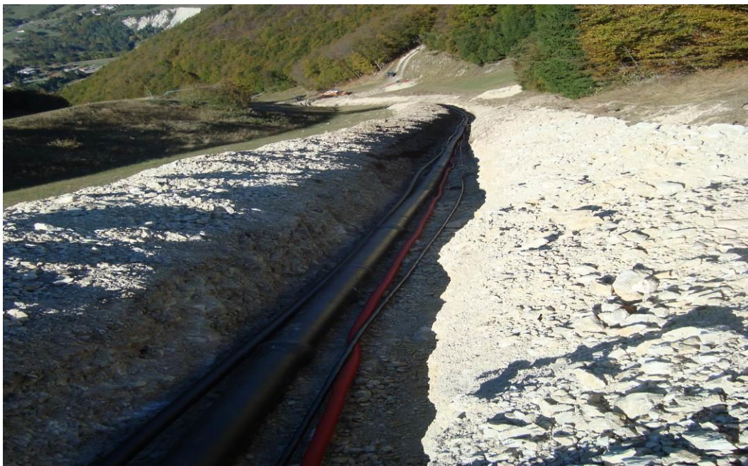
Posa tubazione in ghisa antisfilamento, fibra ottica, cavi Mt in alluminio (240mmq), cavo dati.
