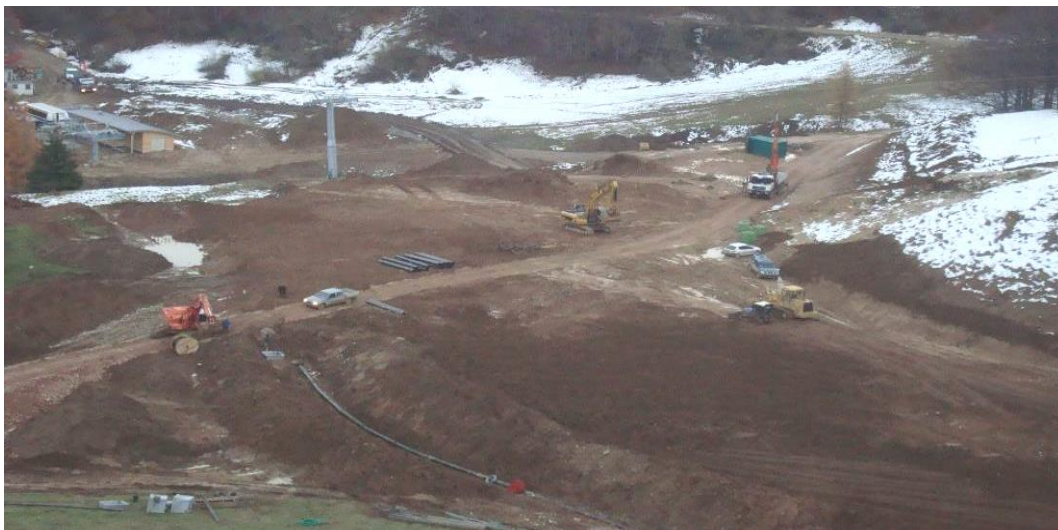
Panoramica con posa tubazione in ghisa, modellazione pista e posa impianto di risalita
