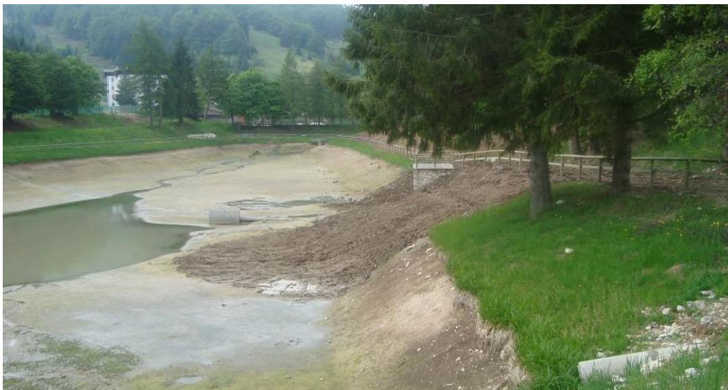
Immagine di cantiere relativa al posizionamento dell'aspirazione centro lago e realizzazione di prima manufatto per pompe sommerse (lago Bucaneve, 15.000mc capienza)
