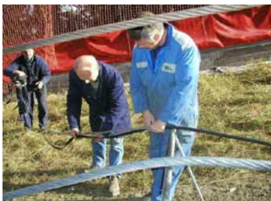
Rivestimento del codino raddrizzato
