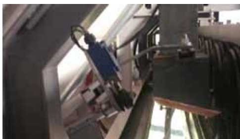
Dettaglio delle celle di carico in fase di taratura
