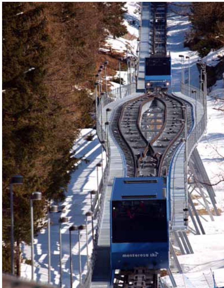
Funicolare terrestre a due veicoli con snodo centrale
