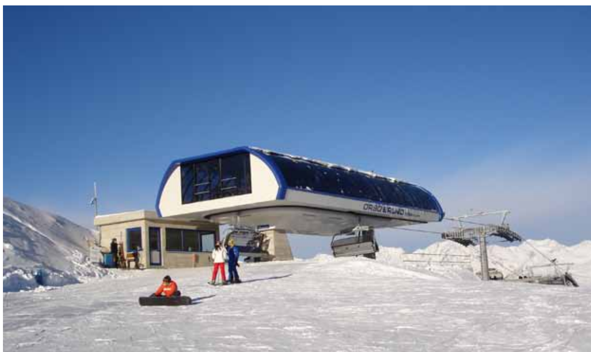
Stazione motrice di un impianto ad ammortamento temporaneo
