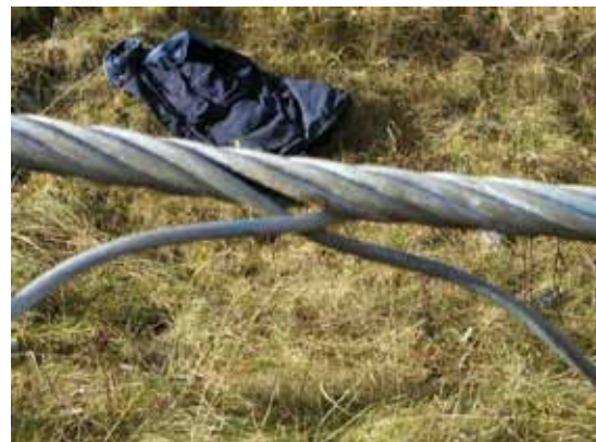
Fase di accostamento dei trefoli sul nodo
