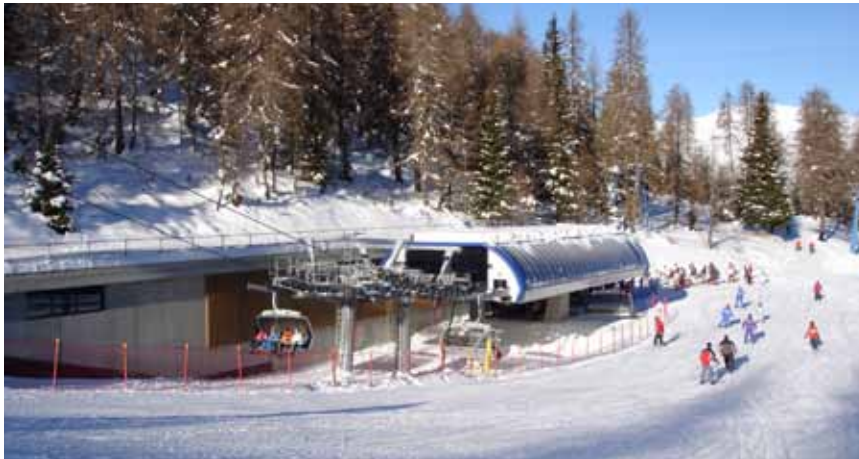
Stazione di rinvio di un impianto ad ammortamento temporaneo
