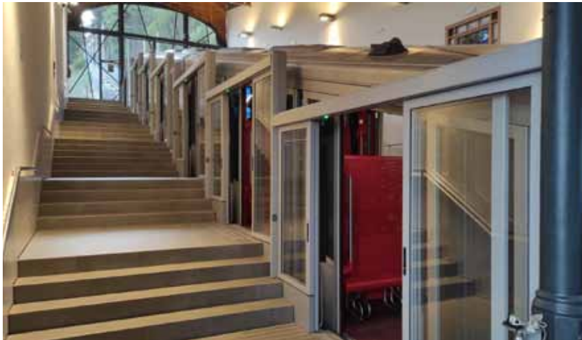
Stazione di valle di una funicolare con zone di imbarco e sbarco
