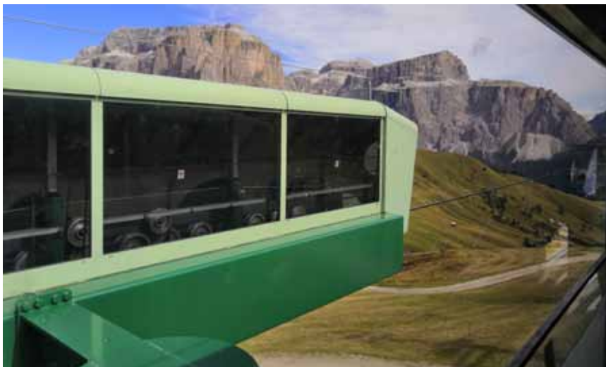
Dettaglio della copertura dei meccanismi del giostazione
