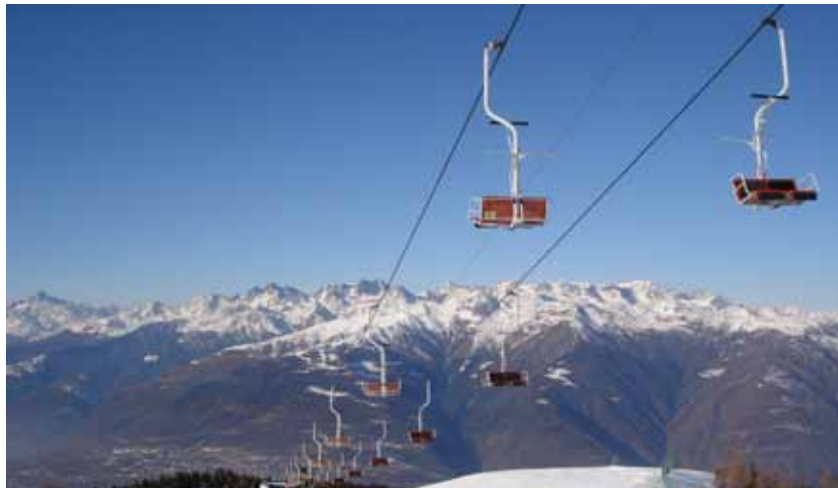
Seggiovia ad ammassamento fisso
