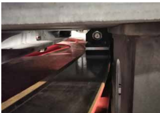
Dettaglio del freno di emergenza di impianto D-line
